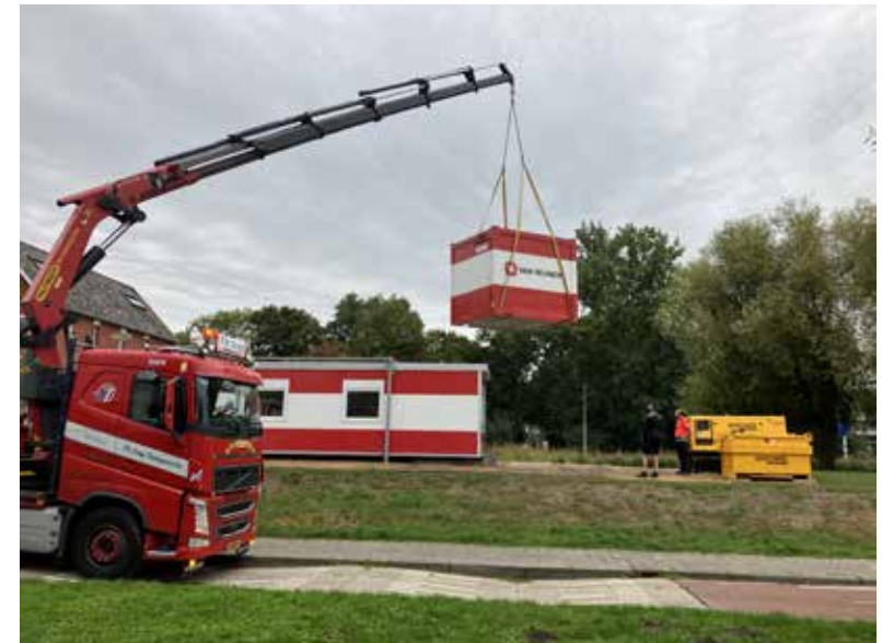
De opbouw van de uitvoering van de versterking
